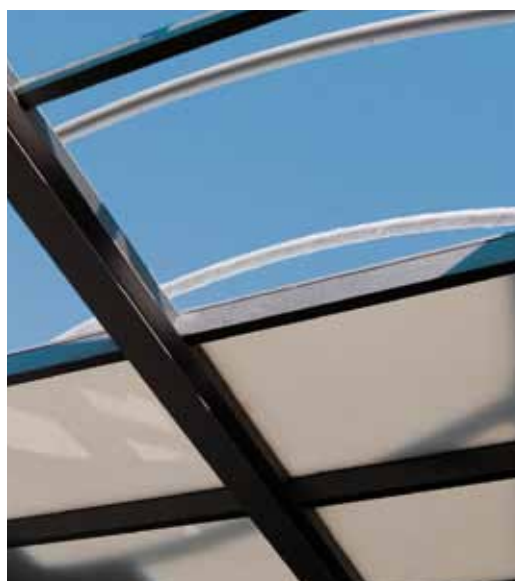
links: Abb. 2: Verringerung von Kühl- und Energiebedarf der Eissporthalle in Landsberg am Lech durch abgehängte Deckenkonstruktion mit low-e Membran (Thermographieaufnahme).
