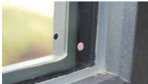
Abb. 4: Sensorspot im Scheibenzwischenraum zur Bestimmung des Gasfüllgrades.
