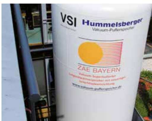
Abb. 4: Installation des optimierten 3. Prototypen eines vakuum-superisolierten (VSI)-Heißwasserspeichers mit 6,5 m 3 Volumen und patentiertem Schichtenlader am ZAE Bayern in Garching. Die Wärmeverluste sind um den Faktor 5 niedriger als bei den besten konventionellen Speichern. Fig. 4: Installation of the optimized third prototype of a vacuum super insulated (VSI) hot water storage device with a volume of 6.5 m 3 and a patented stratification device at ZAE Bayern in Garching. The heat losses are reduced to one-fifth compared to the best conventionally insulated storages.
