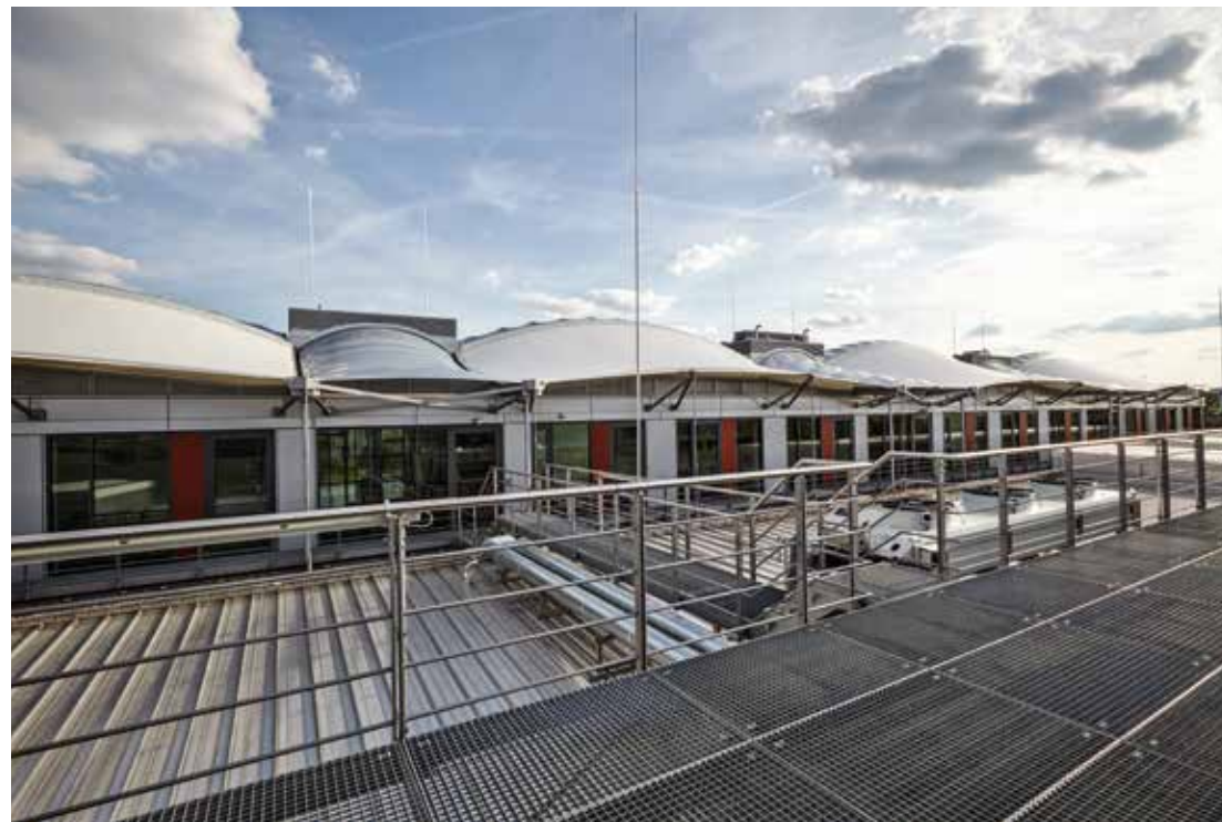
Abb. 11: Blick vom Versuchsdach auf das Dach des preisgekrönten Energy Efficiency Centers Fig. 11: View from the experimental roof of the award winning Energy Efficiency Center
