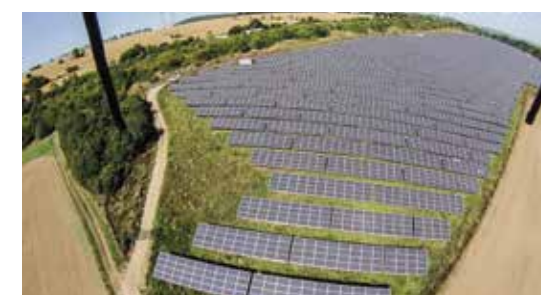
Abb. 3: Luftbild einer großen PV-Installation, die mittels entsprechender IR-Aufnahmen besonders effizient überprüft werden kann
