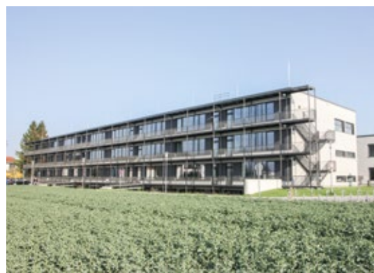
Abb. 1: Passivhaus-Neubau der FOS/BOS Erding. Nordfassade des Schulgebäudes im April 2012. Am rechten Bildrand ist der leicht nach Westen versetzte Südriegel zu erkennen
