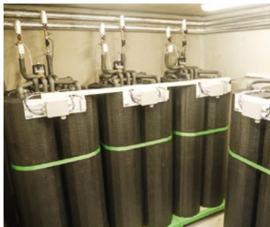
Abb. 2: PCM-Kompaktspeicher für Lüftungssysteme (© Rubitherm Technologies GmbH)
