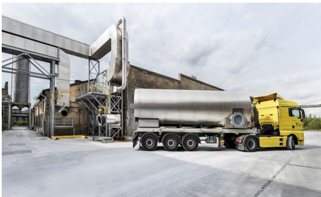
Abb. 1: Mobiler Speicher an der Entladestation (© MHB Hamm Betriebsführungsgesellschaft mbH)
