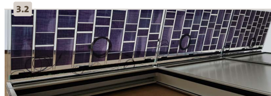
Abb. 3.1, Abb. 3.2: Fassadenintegration von Modulen als Glasvordach in einem Gebäude in Kitzingen
