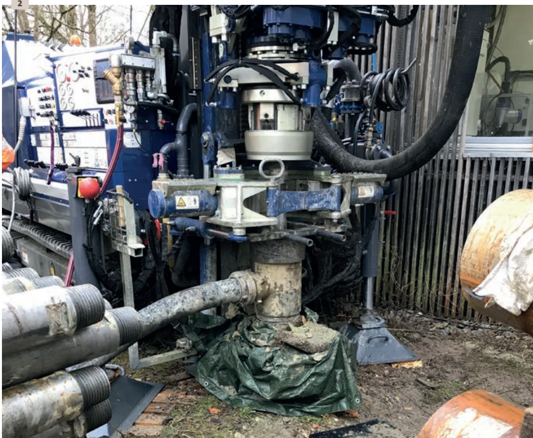
Abb. 2: Bohrarbeiten hinter dem Gebäude des Bereichs ES
