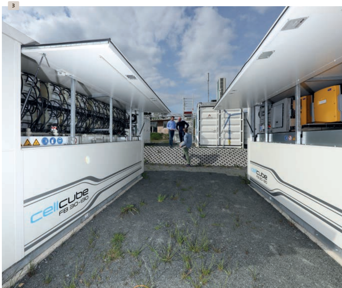
Abb. 3: Vanadium-Redox-Flow-Speicher auf dem Testgelände in Arzberg
