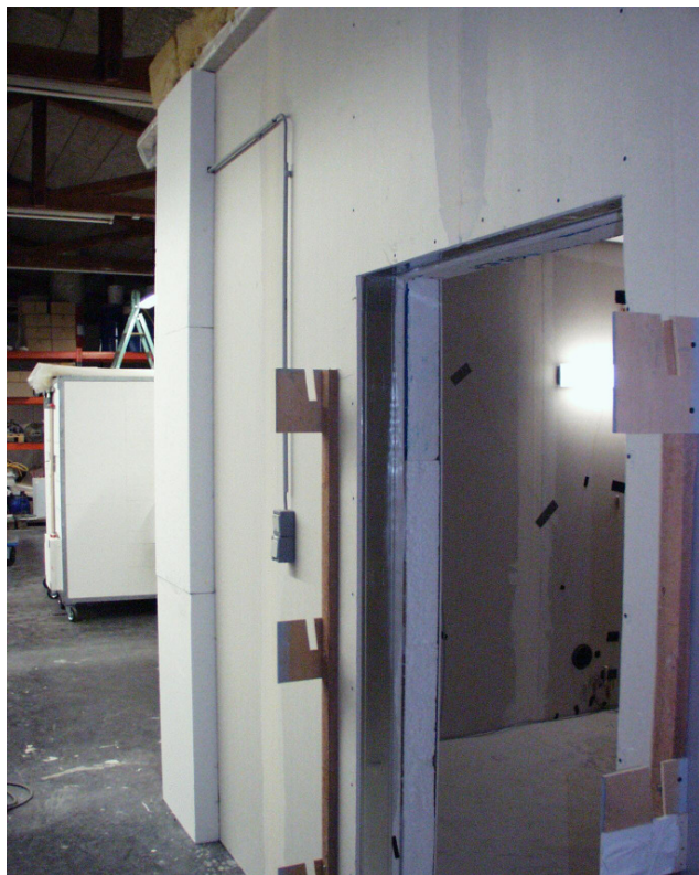
Abb. 1: Außenansicht des Testraums. Im Innern sind zahlreiche Temperatursensoren zur Erfassung des Raumklimas angebracht.
