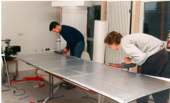
Abb. 2: Herstellung von Vakuumdämmelementen der Größe 290 x 90 cm; im Hintergrund: zu dämmende Heizkörpernische mit Röhrenheizkörper
