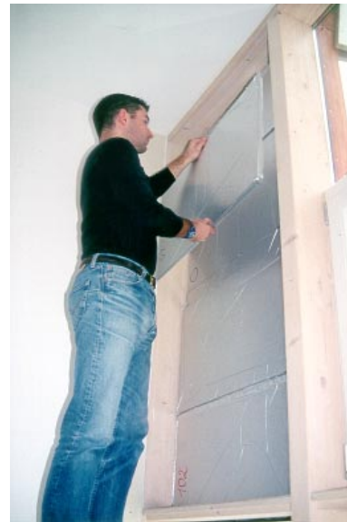
Abb. 1: Einbau einzelner Vakuumdämmpaneele in die Gebäudefassade des ZAE Bayern
