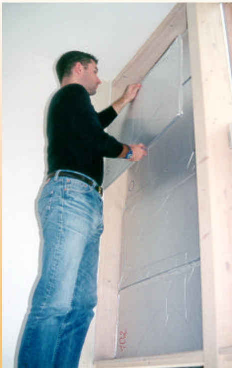
Einbau der Einzelpaneele
