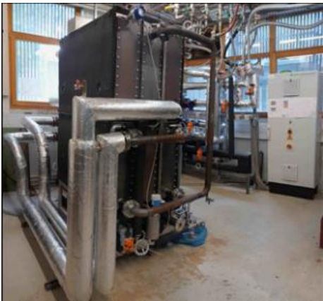
Einstufige AWP & Visualisierung einer Anlagensteuerung
